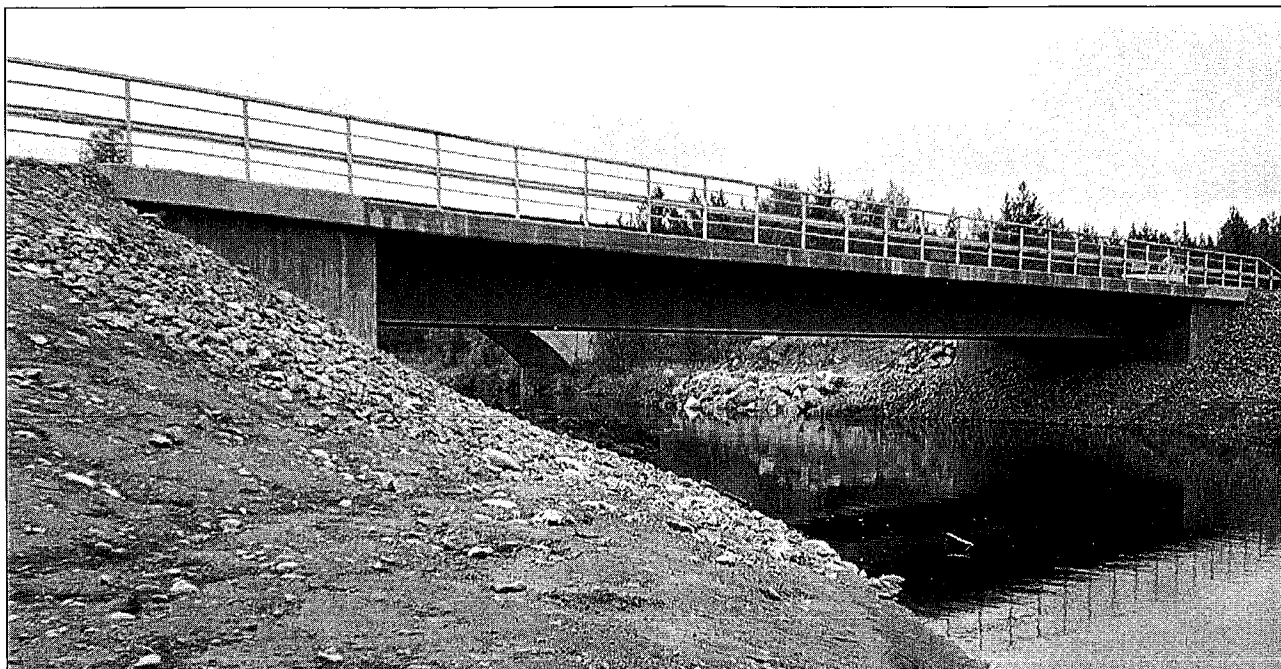
Bro över Fjällån, Västerbotten. Samverkansbro med integrerade landfästen. Spännvidd 37 meter.
